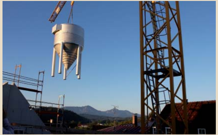
Die neuen Tanks werden angeliefert
